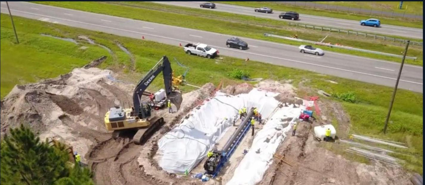
Para este tipo de proyecto se utiliza una técnica de alta precisión ideal para proyectos de gran envergadura, como la canalización de tuberías de gran diámetro (36 a 42 pulgadas) bajo carreteras y áreas urbanas. Este método permite realizar el proceso de perforación y encamisado en una sola fase, lo que acelera considerablemente la instalación y minimiza el tiempo de intervención en la superficie.
